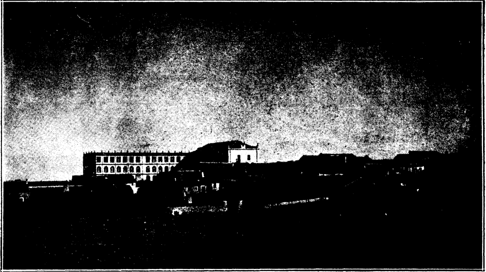
Vista general del Colegio
